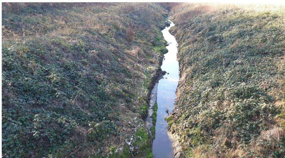
Abbildung 1: Stark überprägter, mit Sohlschalen ausgebauter Oelbach
