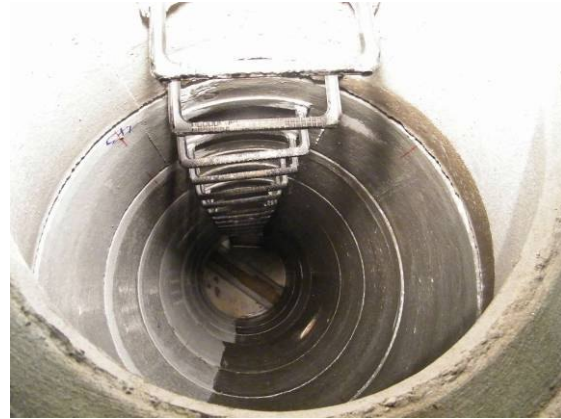
Bild Nr.2: Blick in ein Schachtbauwerk
