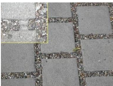
Abb. 4: Sickerfugenstein mit Abstandhaltern
