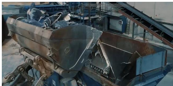
Abbildung 19: Paneele werden in einen Schredder gehoben (Bild: Reiling GmbH)
