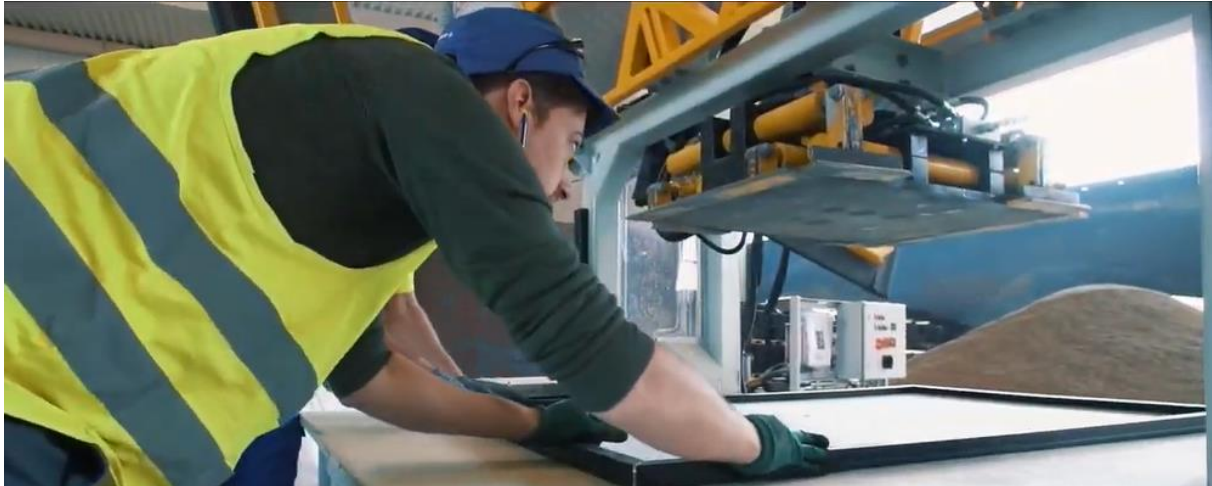
Abbildung 18: PV-Module werden für die Demontage in Position gebracht (Bild: Reiling GmbH)
