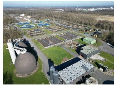
UAV-Aufnahme der Hauptkläranlage Münster
