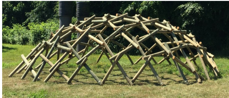
Abb. 1: Mit Studierenden gebaute Flechtwerkschale an der Hochschule Bochum
