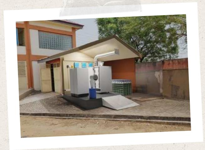
↳ Realisierungskonzept für eine mit Solarenergie betriebene Wasserstofferzeugungs- und -speichereinheit mit einem 20kW PEM-Elektrolyseur und einer 10kW Brennstoffzelle
